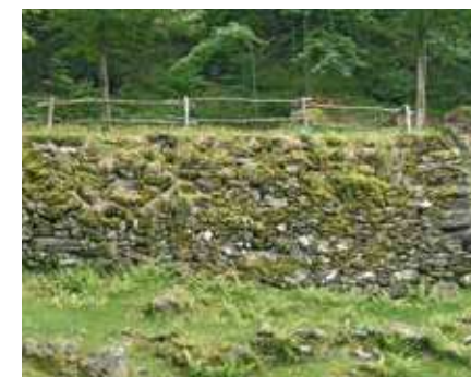
• Muro a secco vegetato.
