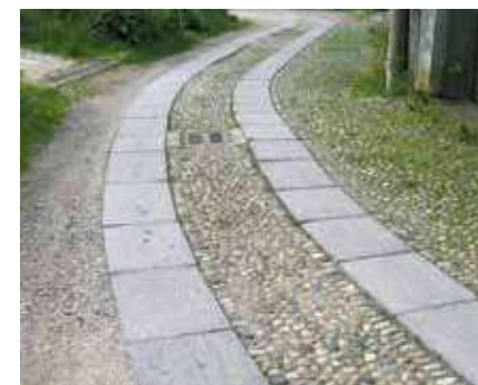
• Acciottolato con lastre disposte su due corsi.
