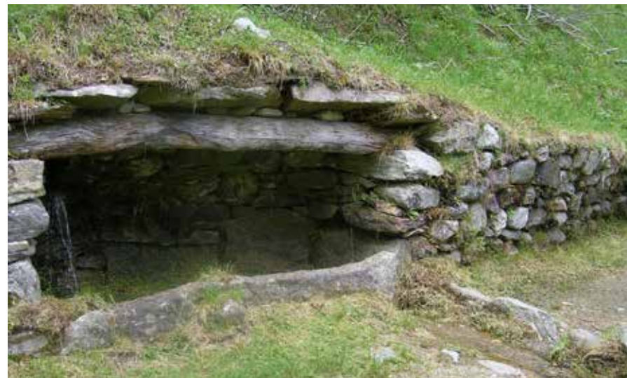
• Comune di Traversella.
