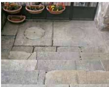
• Pavimentazione in selciato.
