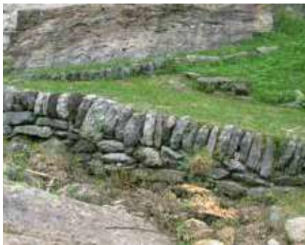
• Muro di contenimento presso un sentiero.
