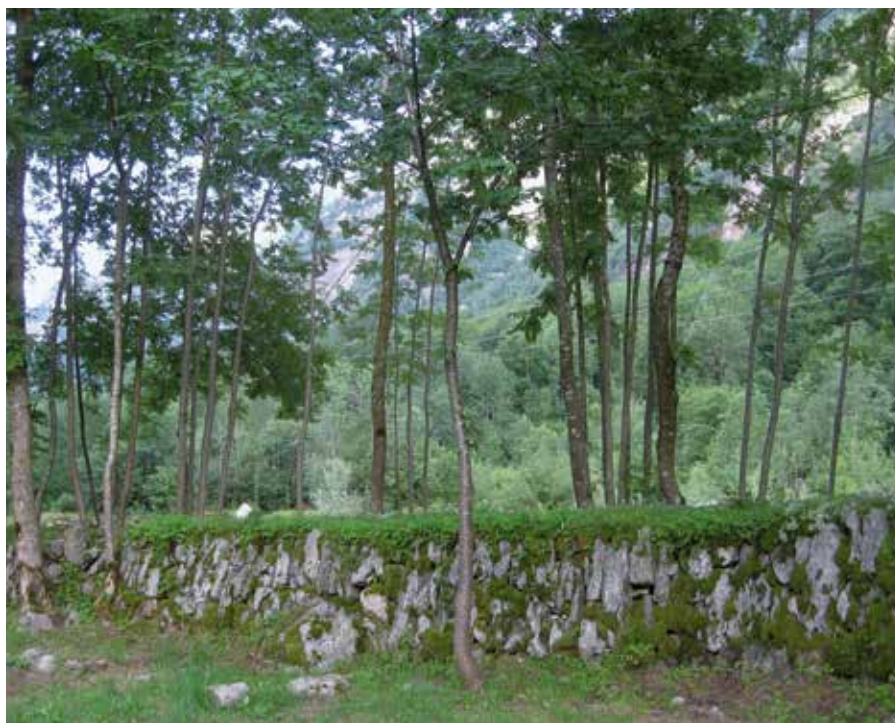
• Filare e muro da spietramento lavorato per ostacolare le piene del torrente.
