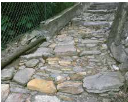
• Pavimentazione in selciato.
