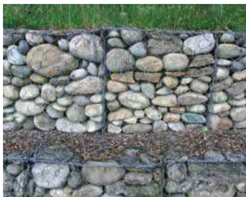
• Gabbionata Di recente realizzazione.
