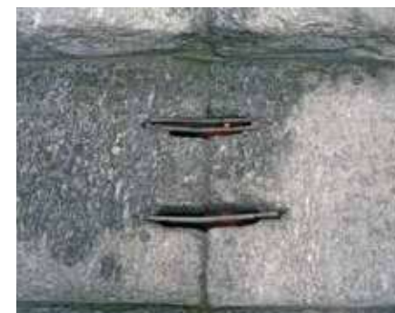
• Particolare caditoia in pietra.
