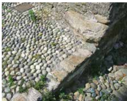
• Pavimentazione in acciottolato.
