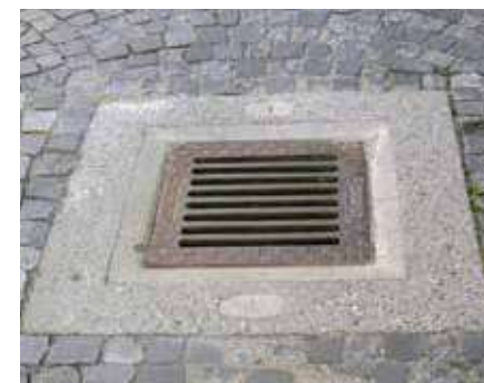
• Particolare caditoia in pietra.
