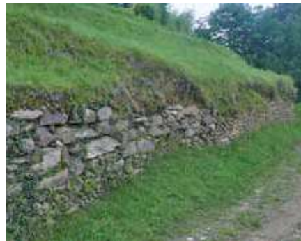
• Muro di sostegno di scarpata.
