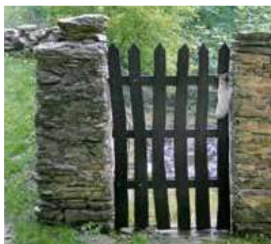
• Muretto in pietra di recinzione di orto.
