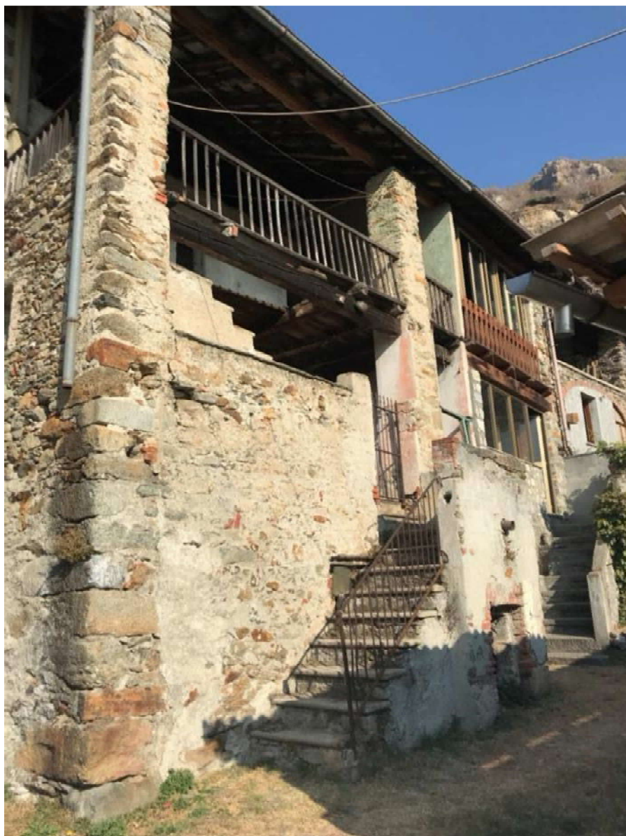
Figura 105 loggiato con piano terra chiuso da muratura
