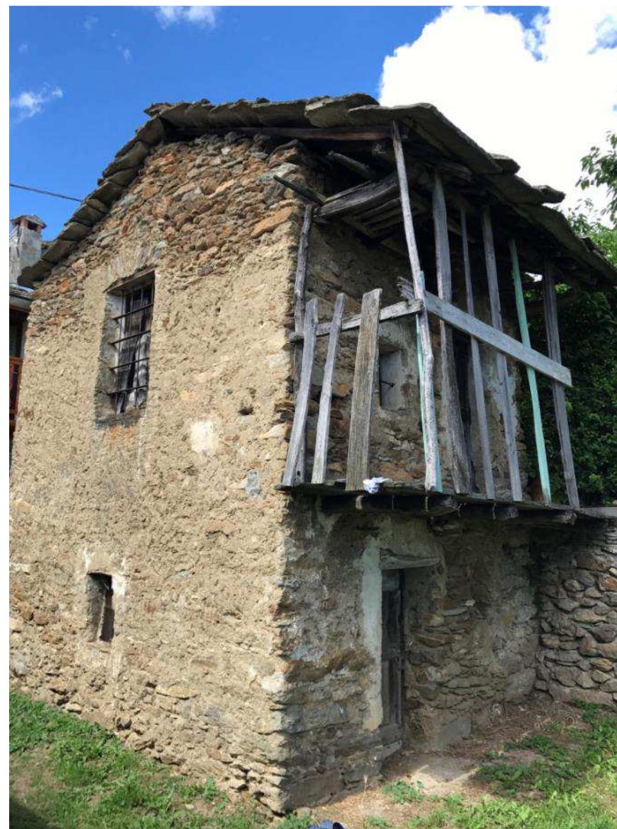
Figura 95: ballatoio con parapetto in listelli verticali
