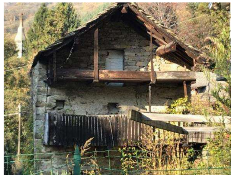
Figura 98: ballatoio all'ultimo piano con un'unica tavola lignea
