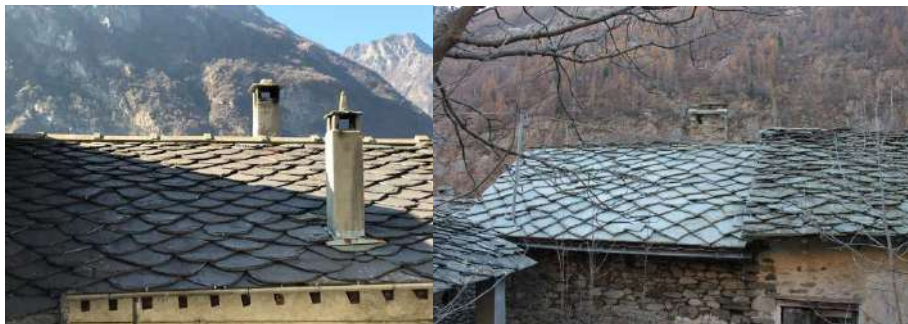
Figura 5: losa a goccia e losa quadrata
