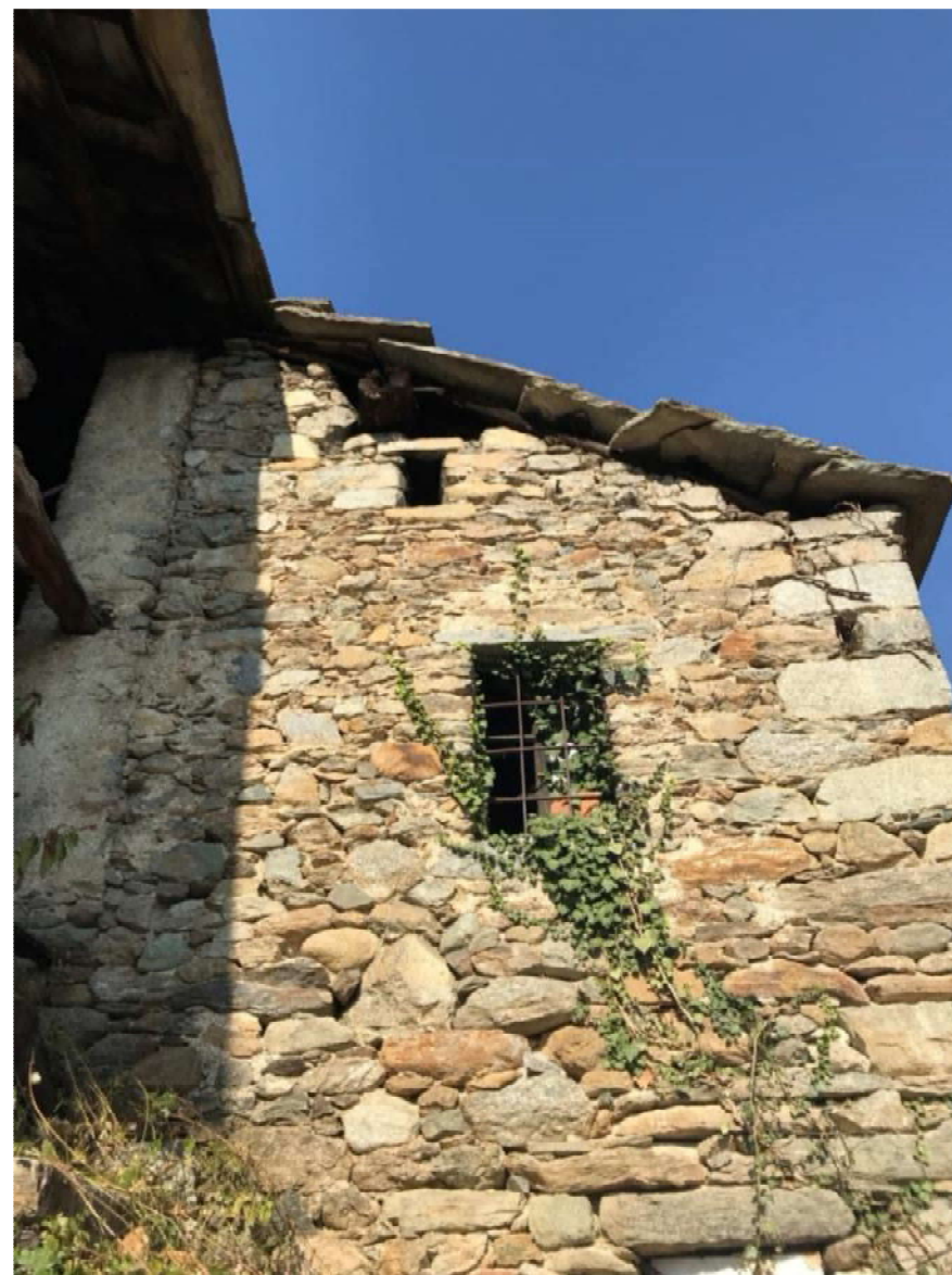
Figura 68: corsi irregolari, posa casuale, collegamento angolare irregolare
