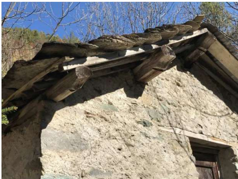
Figura 6: lose sporgenti rispetto al filo muro
