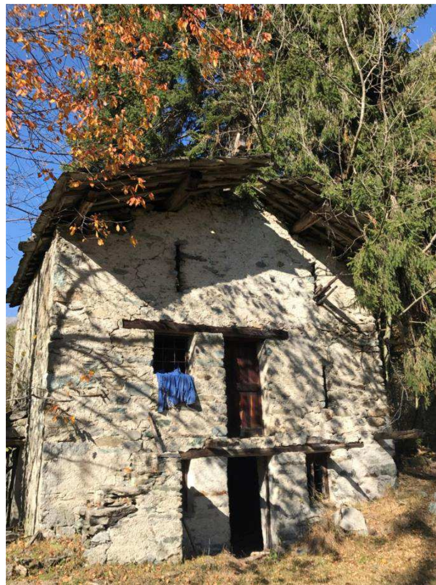
Figura 42: architrave ligneo passante sopra porta e finestre
