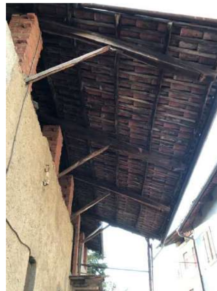
Figura 16: sporto maggiore con prolungamento falsi puntoni e sostegni lignei. Chiaverano
