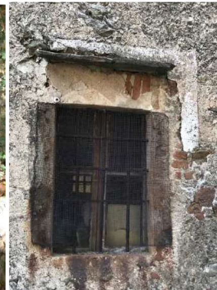
Figura 50: architrave in conci di mattoni
