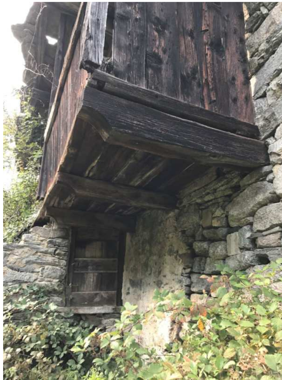
Figura 103: particolare dell'aggancio travi - muratura-ballatoio
