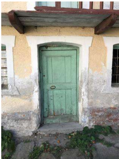
Figura 57 ingresso con fascia intonacata
