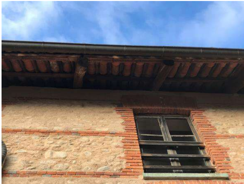
Figura 89: muratura in pietrame con ricorsi in laterizio
