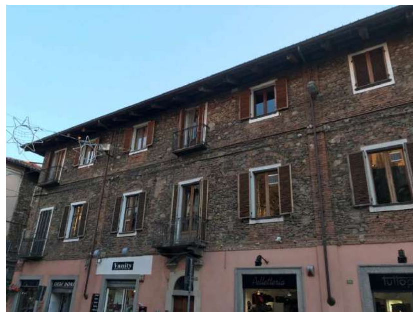
Figura 83: Castellamonte. Muratura in pietra e laterizio
