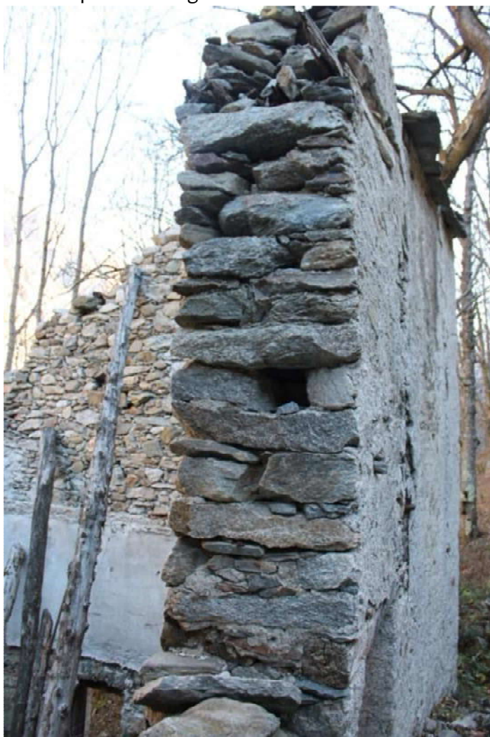
Figura 74: sezione trasversale a paramenti ammorsati – Frazione Borno Noasca
