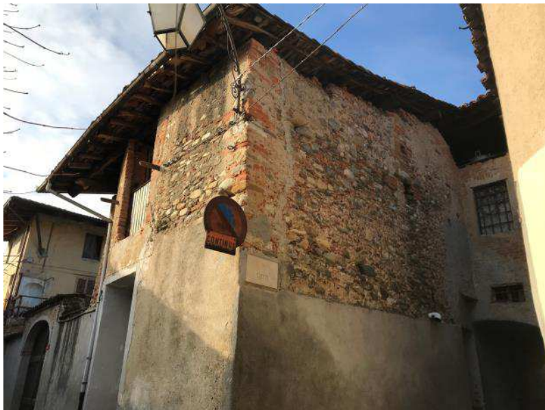
Figura 89: muratura in pietrame con ricorsi in laterizio
