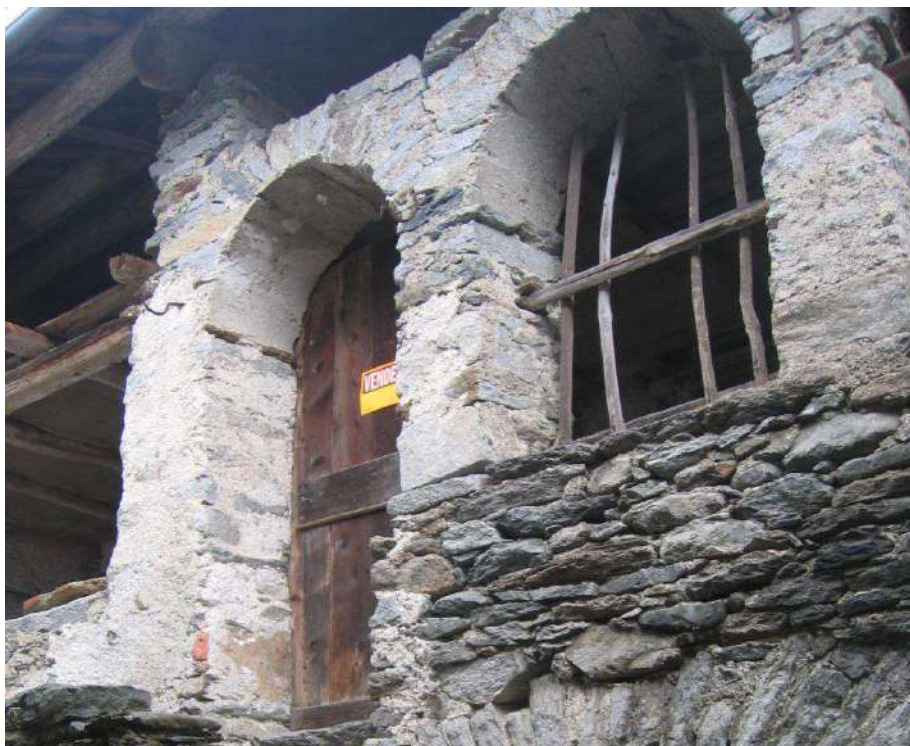
Figura 51 portone di ingresso in ambito rurale
