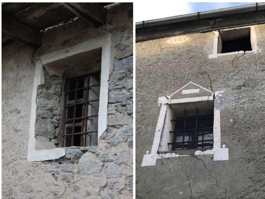
Figura 33: vano in muratura e cornice intonacata
