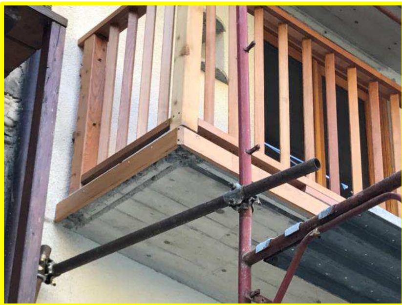
Figura 108 soletta in cls mascherata con profili lignei
