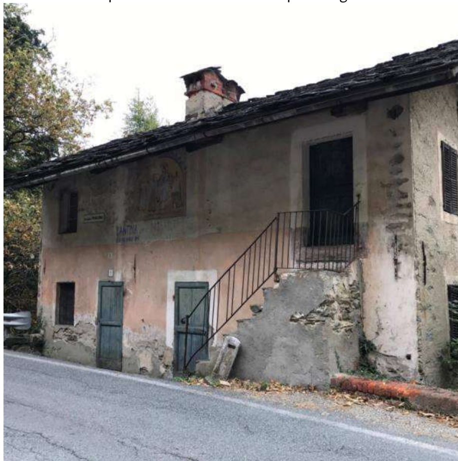
Figura 92: scala in pietra intonacata e ringhiera metallica
