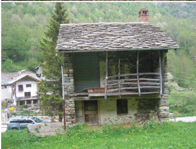
Figura 94: ballatoio con montanti lignei e parapetto in listelli orizzontali
