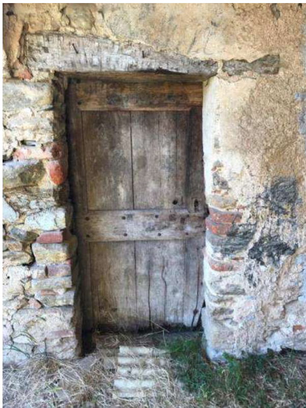
Figura 35: architrave in legno intonacato
