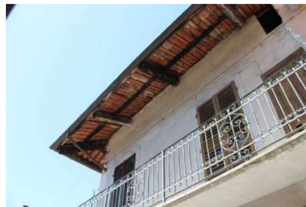
Figura 15: sporto del tetto con prolungamento dei falsi puntoni –Agliè
