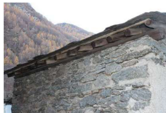
Figura 2: particolare della trave dormiente sul muro perimetrale
