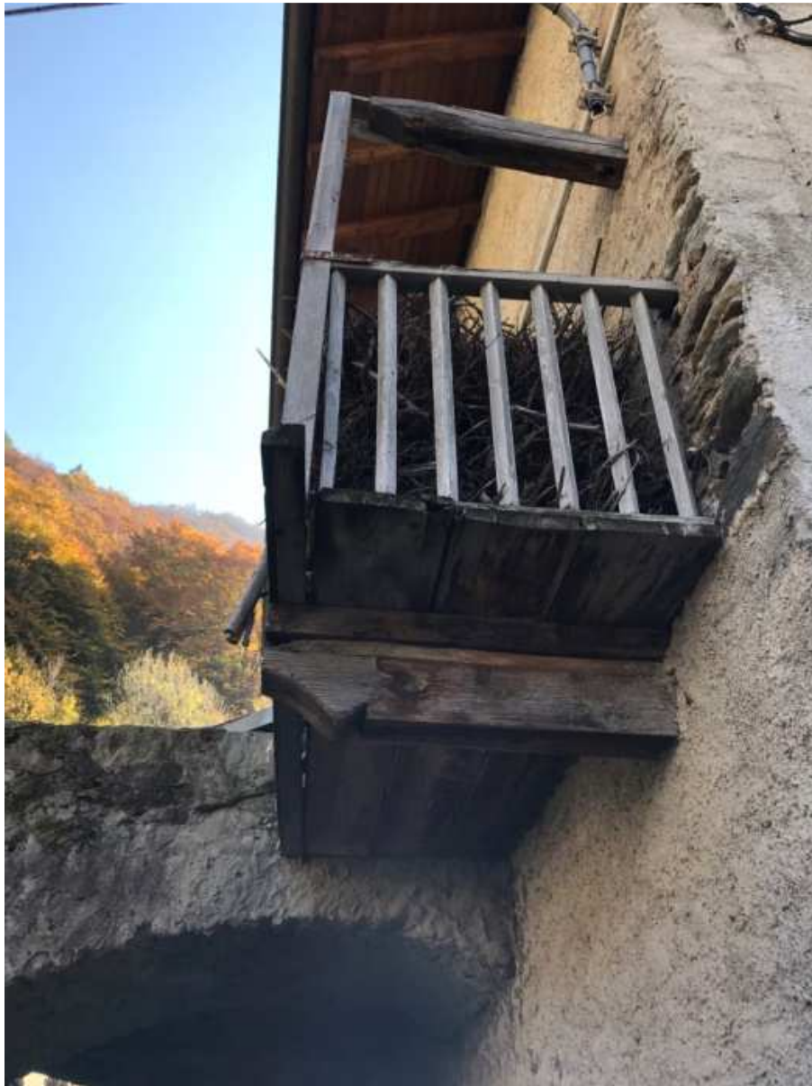
Figura 104: particolare dell'aggancio ballatoio-muratura-travi
