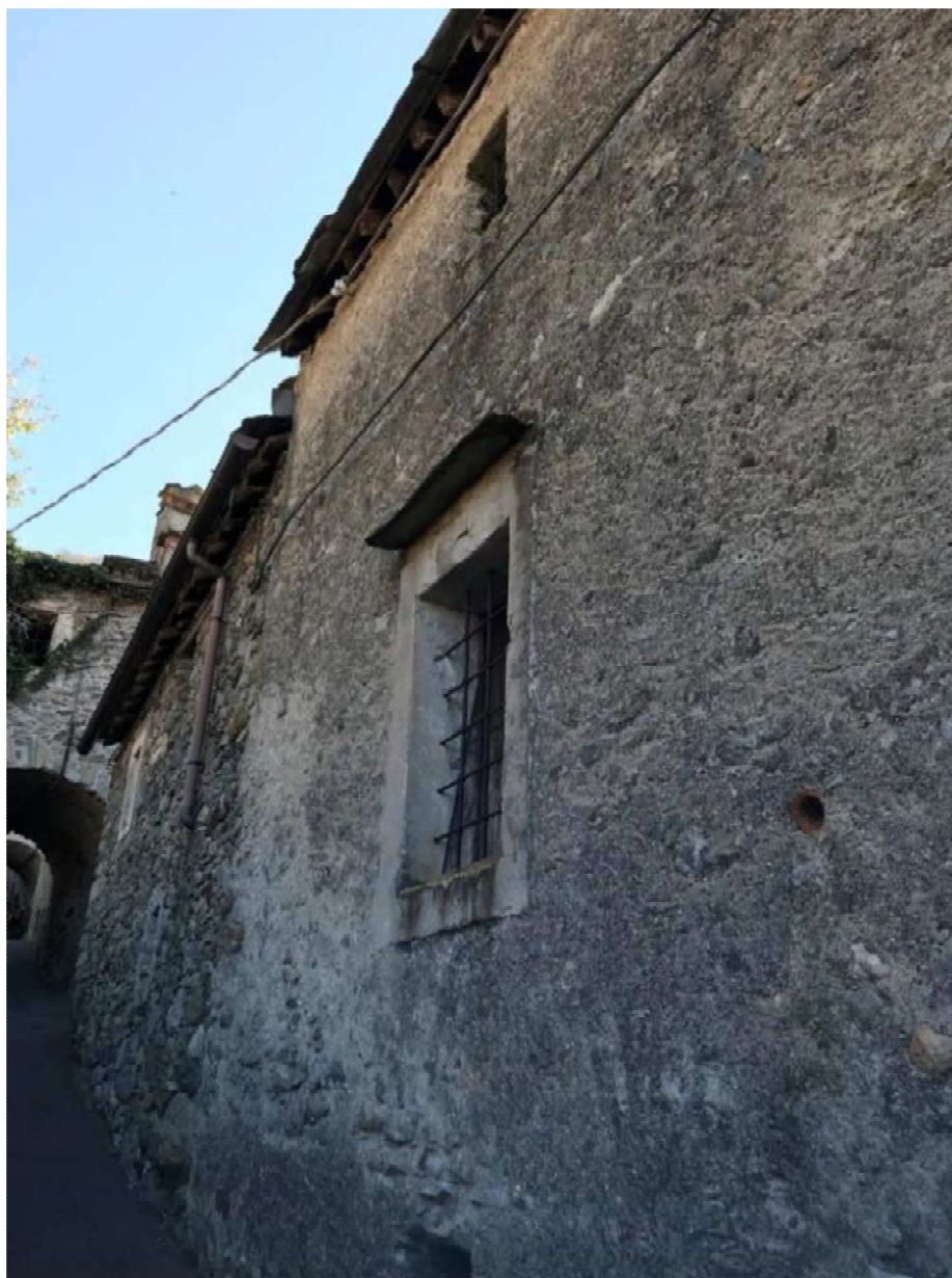
Figura 70 muratura con intonaco raso pietra - Carema
