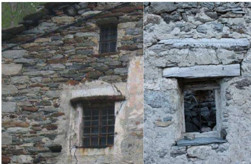
Figura 40: architrave in pietra e cornice intonacata
