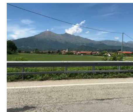
Guard rail e strutture di sostegno stradali
