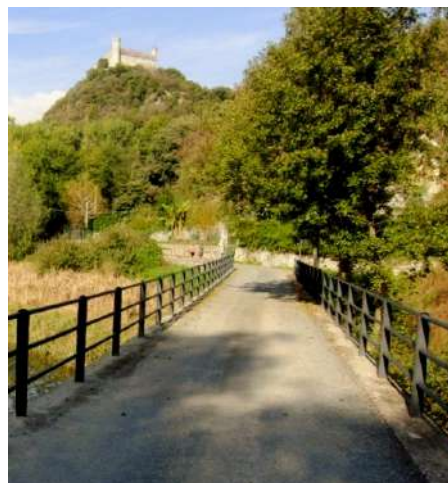
Attraversamento lungo il Lago Pistono
