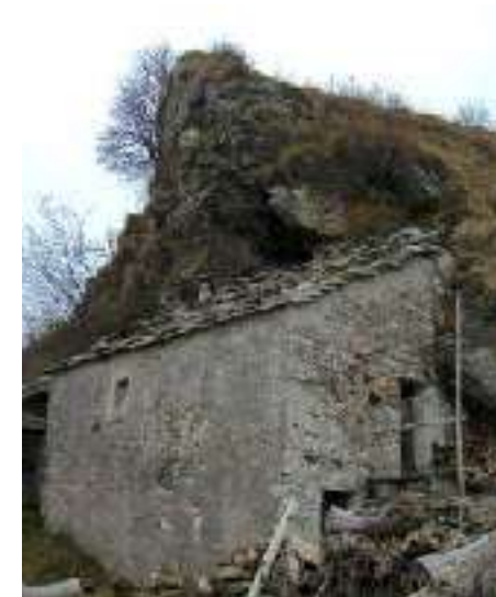
Edificio in pietra addossato alla roccia
