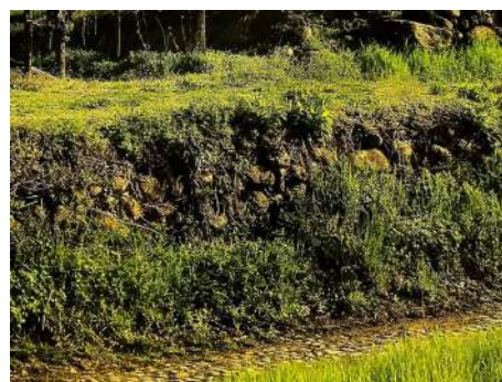
Muretto di contenimento a Cuceglio
