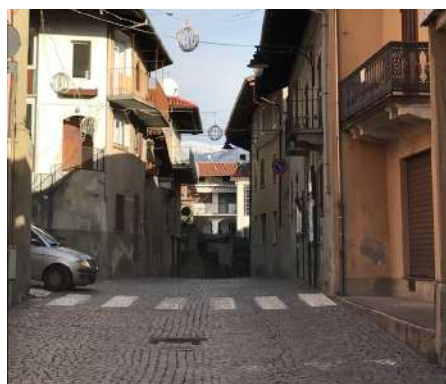
Pavimentazione in cubetti di pietra a Lessolo
