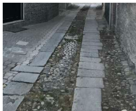
Acciottolato con lastre di dimensioni differenti disposte su due corsi accostato a autobloccanti in cemento.
