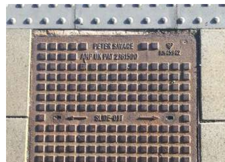
Pavimentazione tattile chiusino
