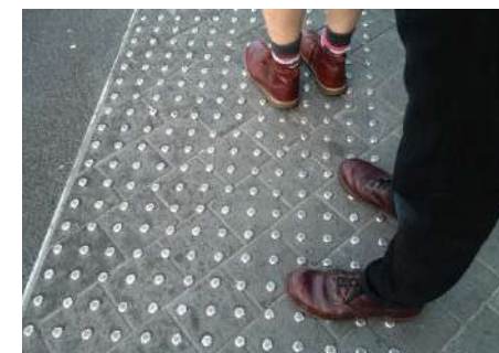
Pavimentazione tattile per percorsi
