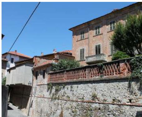
Muri di contenimento in pietra e laterizio.
