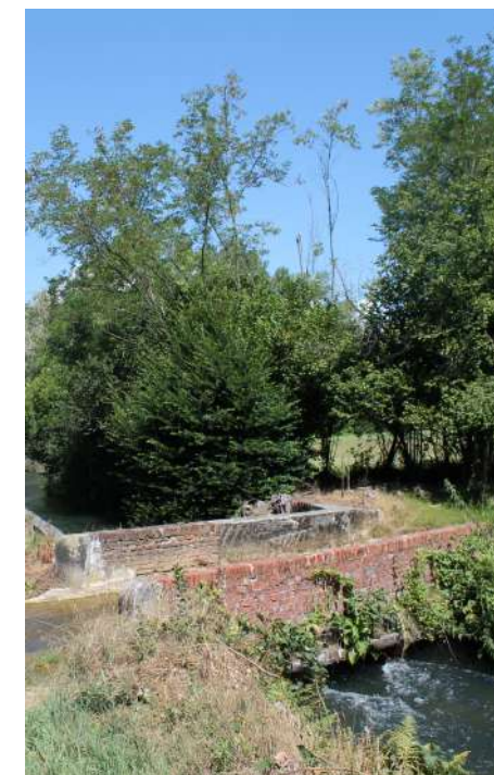
Canali, sponde e attraversamenti
