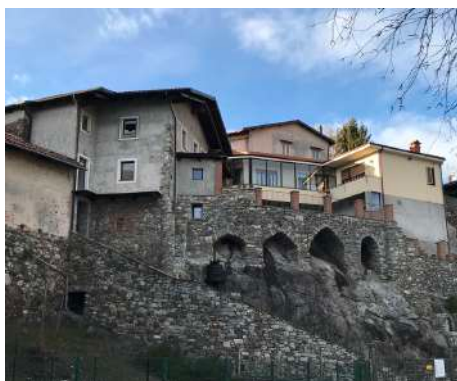
Muri di contenimento ad archi in pietra.
