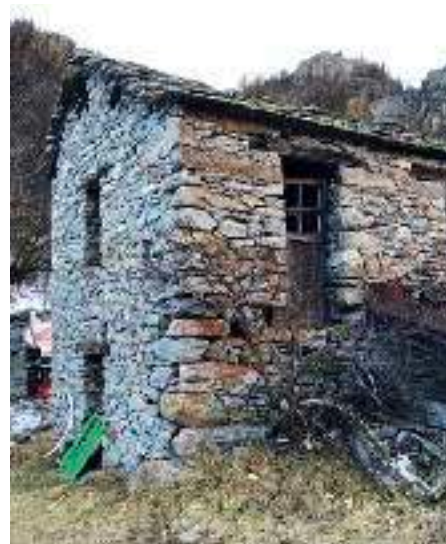
Edificio stagionale in pietra a due piani
