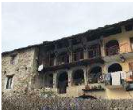
Casa ad archi e loggiati con ballatoio
